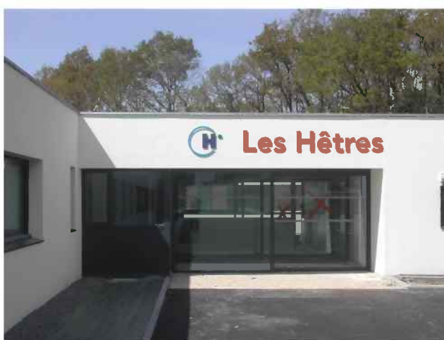
Entrée principale du bâtiment
